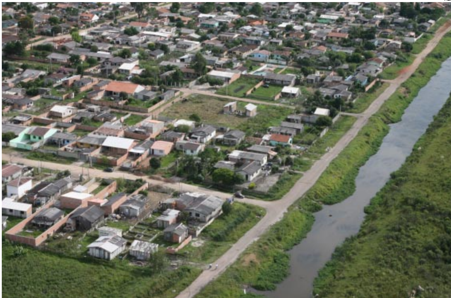
Guarituba: intervenção do Governo do Estado garante melhorias em infraestrutura e moradia
